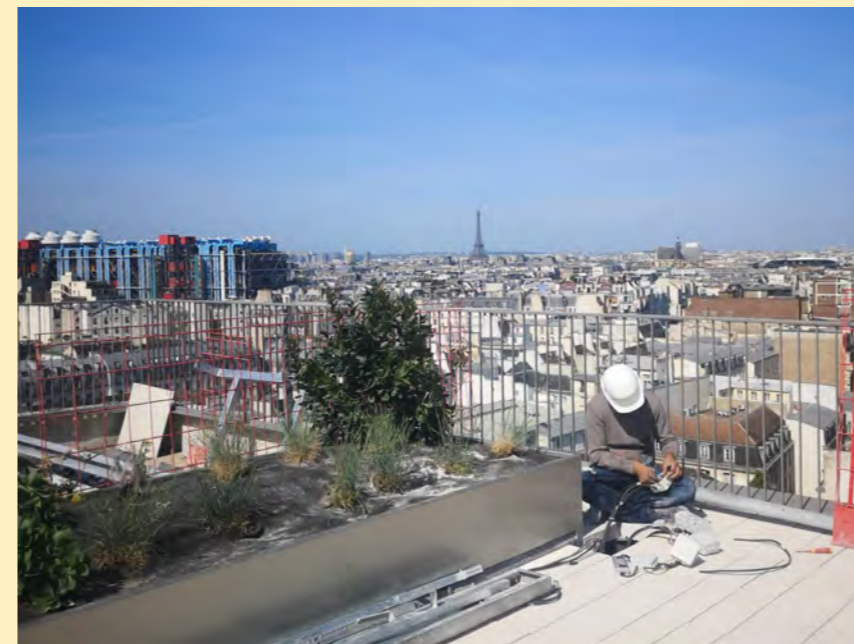
• LA FONTAINE DES INNOCENTS AVEC SUNMETRON, 2024 • TOITURE DU 106 TEMPLE AVEC FRANKLIN AZZI, 2023
