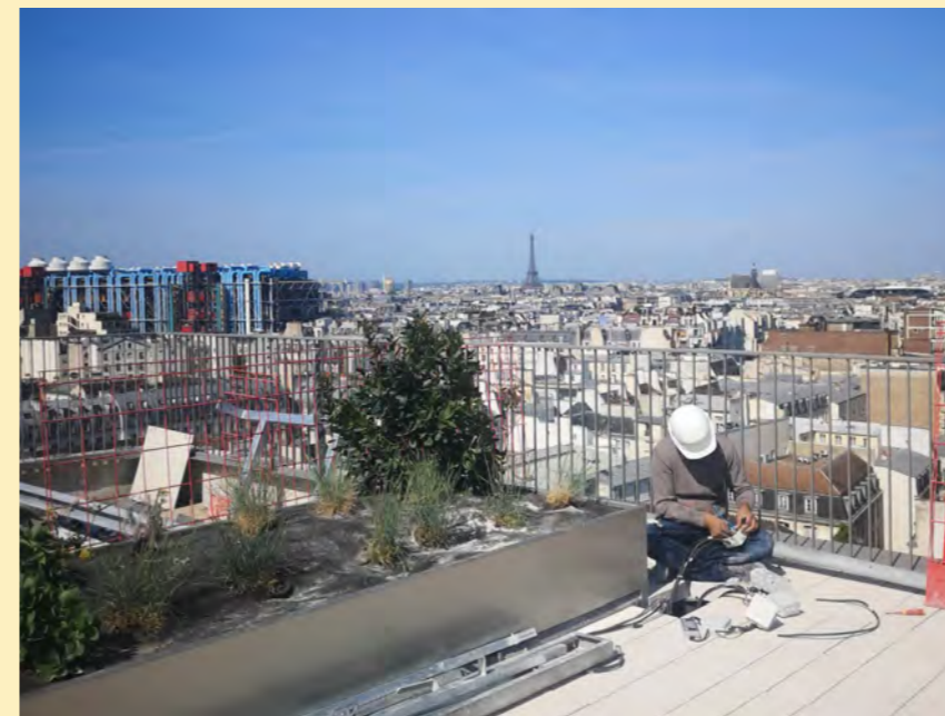
• LA FONTAINE DES INNOCENTS AVEC SUNMETRON, 2024 • TOITURE DU 106 TEMPLE AVEC FRANKLIN AZZI, 2023
